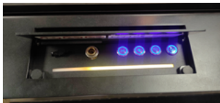
Abb. 9-53 Kamin mit 60% Heizleistung
